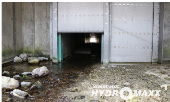
Gesteuerte Abflussöffnung mit Notfallschütz und zusätzlichem Grundablass auf der rechten Seite.
