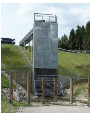
Dombauwerk mit Treibholzschutz aus Pollern und Gittern
