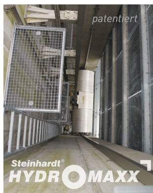
Blick in das Dombauwerk mit vertikal verfahrenem Schwimmer.
