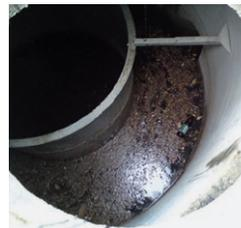
Der patentierte **HydroTwister®** ist als dynamischer Abscheider ausgelegt. Zusätzlich stehen verschiedene Siebrechenoberflächen und Öffnungsdurchmesser für unterschiedliche Durchflüsse und Behandlungsziele zur Verfügung.
