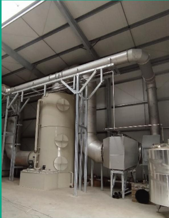
Die neue Anlage reinigt 60.000 m<sup>3</sup>/h geruchsbelastete Abluft.
