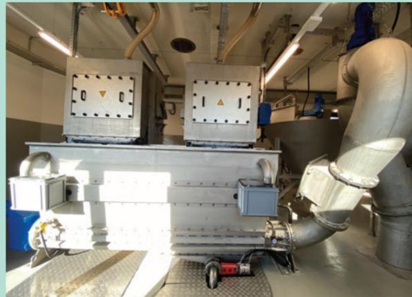
Die solide Rechengutwaschpresse befreit das Rechengut von organischen Bestandteilen und presst das Rechengut auf hohe Trockensubstanzwerte. Außerdem setzt der Verband auf einen von FSM neu konzipierten Amphibienausstieg, der täglich vielen Tieren das Leben rettet. In der Rechengutwaschpresse wurden Ausstiegshilfen installiert, die den Fröschen, Kröten und Salamandern eine Fluchtmöglichkeit bieten. Der Ausstieg ist wartungsarm, so dass der Aufwand für den Betreiber gering ist.
