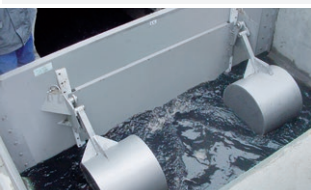
HydroStyx® Abflussbremse mit gesteuertem Grundablass
