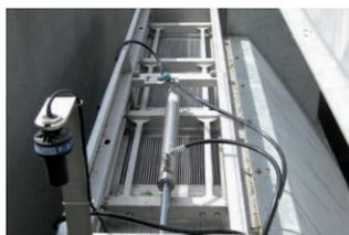
Der **Steinhardt® Hydro-Screen Fein-Stabrechen Typ FSRF** wird an Überläufen der Misch- und Trennkanalisation horizontal, das heißt flachliegend, eingebaut. Er wird also von unten nach
