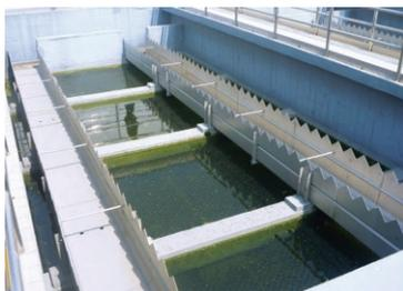
Das Konzept des **HydroM.E.S.I.®** beruht auf einem flexiblen, modular erweiterbaren System zur hocheffizienten Abscheidung von Feinpartikeln aus Misch- und Regenwasserabflüssen mittels Sedimentation. Der **HydroM.E.S.I.® Partikelabscheider Typ STATIC** ist sowohl für die Einplanung resp. Nachrüstung in zentrale Sedimentationsanlagen als auch für den Einsatz in dezentralen Behandlungssystemen geeignet.
