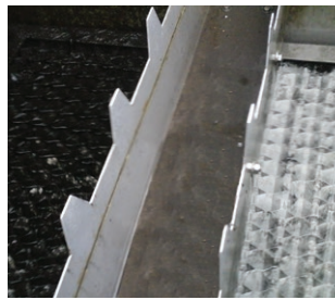
HydroM.E.S.I.® mit Wabenstruktur Links: mit Sediment Rechts: nach der Reinigung
