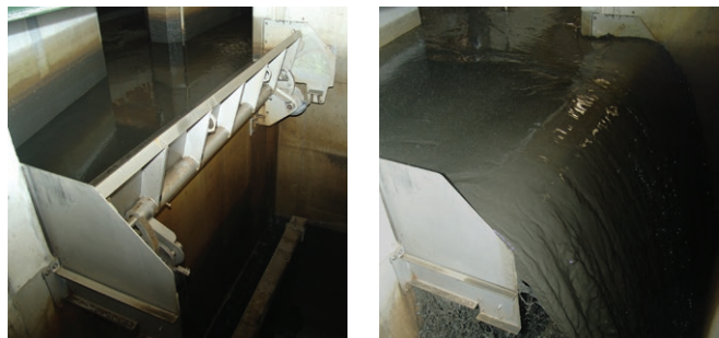
HydroBend Wehrklappen im Kanal, fremdenergiefrei
