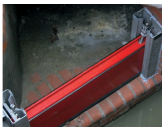
Sicherung eines Notüberlaufs
