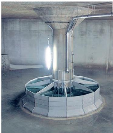
Die **HydroSelf® Behälterspülung für Rundbecken und kleine Rechteckbecken** ist eine Behälterspülung. Sie steht auf einer Grundplatte mit mittlerer Führungsstange, an der die Behälterführung und der Verschluss angeordnet sind. Die runde oder eckige Außenwand ist zugleich Speicher-
