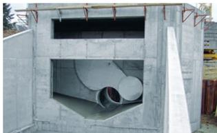
Durch seine robuste Mechanik ist der **HydroSlide® Abflussregler Typ MINI** auch hervorragend zum Einsatz im **Hochwasser-rückhalt** geeignet.
