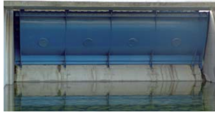
Abb. 1: Fischbauchklappe
