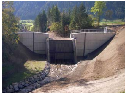
Abb. 4: Geröllfang u. Drosselbauwerk
