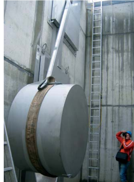
Abb. 5: HydroSlide® Drosselbauwerk
